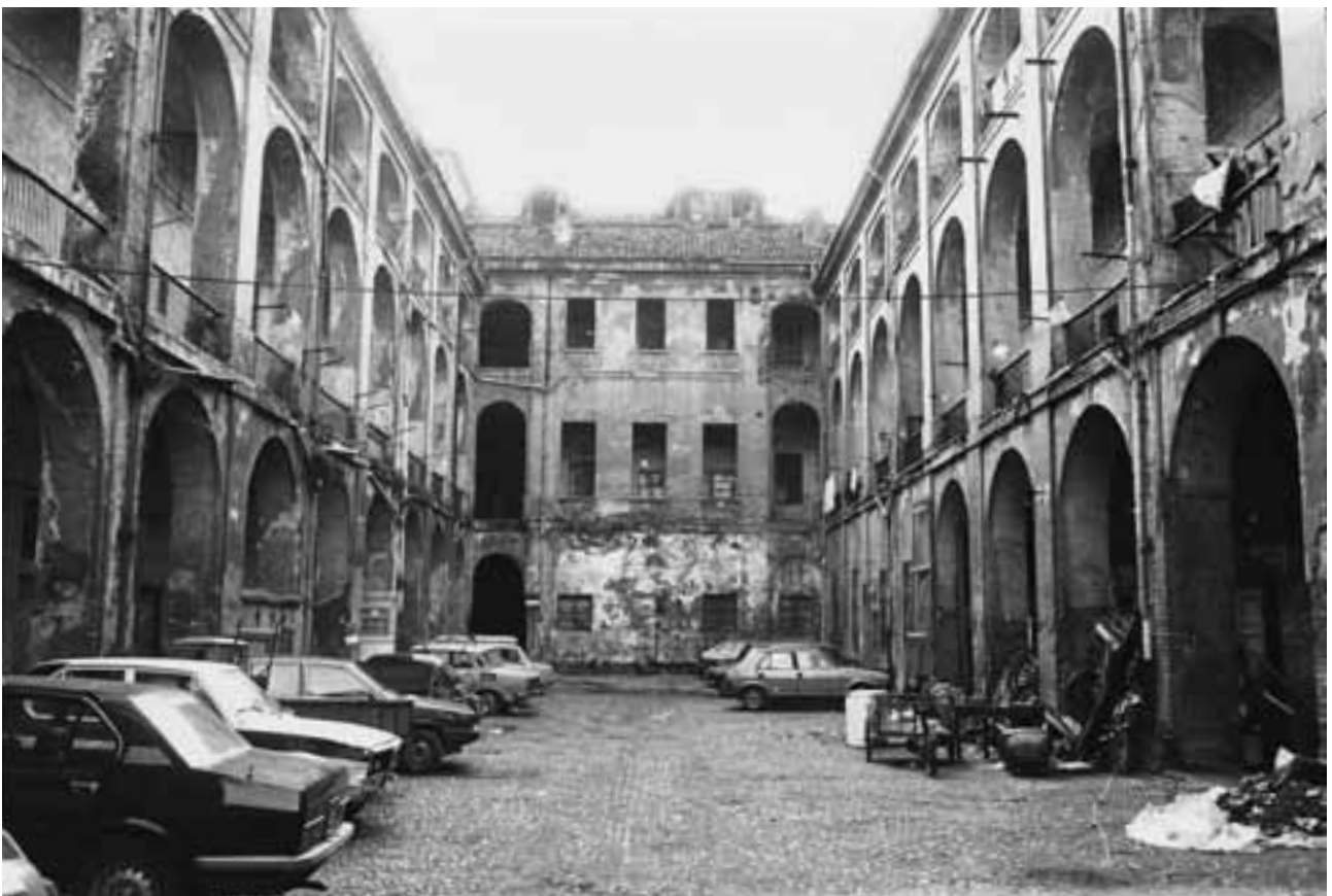
16. Alessandria, Hof des Kollegs (Zustand 1982).
