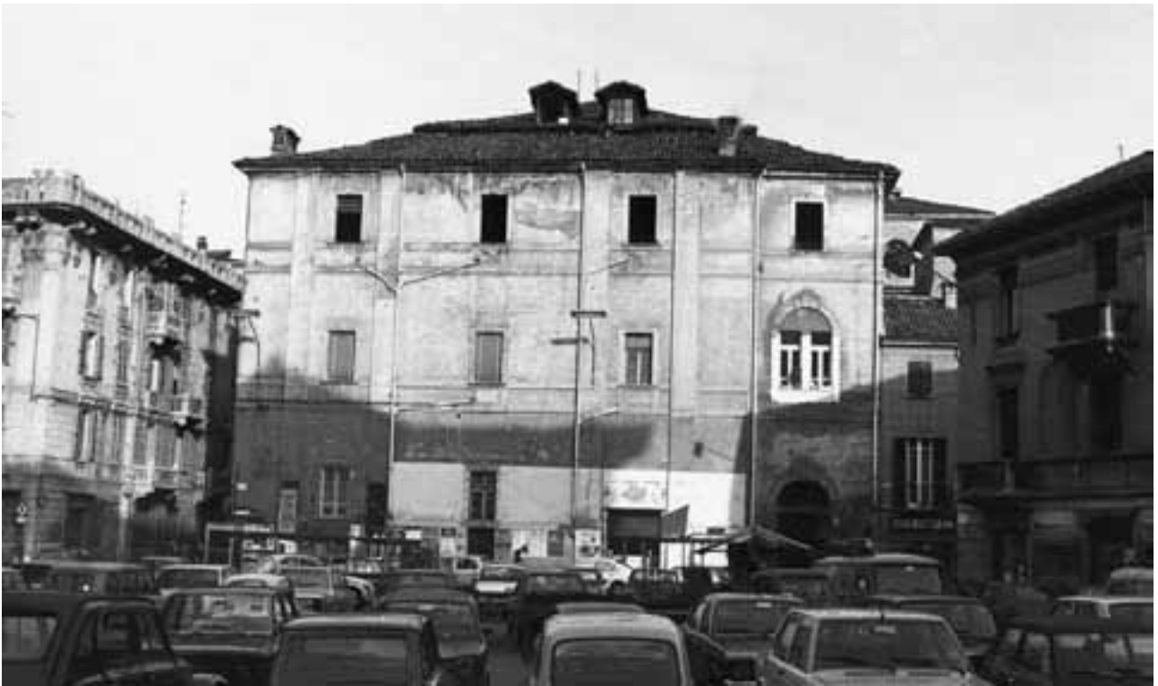
15. Alessandria, ehemalige Kirchenfassade (heutiger Zustand).
